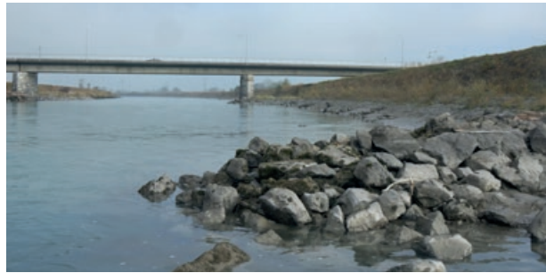
Typ D2: Blocksteinufer/-buhnen strukturreich
